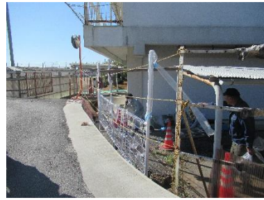
(フェンス工事)
